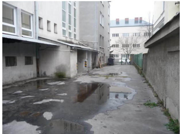
Dvor na parc.č.104/1 – asfaltová plocha
