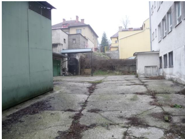
Dvor na parc.č.104/2 – betónová plocha
