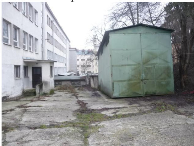
Dvor na parc.č.104/2 a ocel'ový prístrešok pre prenosový voz
