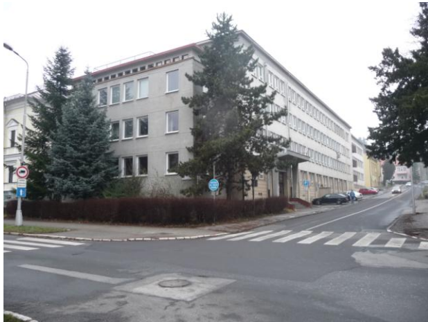
Budova súp.č.1716 na parc.č.104/1 - pohľad od ulice
