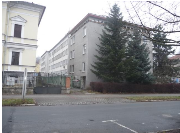
Budova súp.č.1716 na parc.č.104/1 - pohľad od ulice
