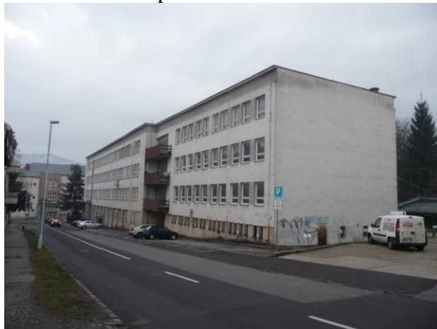
Budova súp.č.485 na parc.č.104/2 - pohľad od ulice
