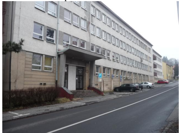
Budova súp.č.1716 na parc.č.104/1 - pohľad od ulice
